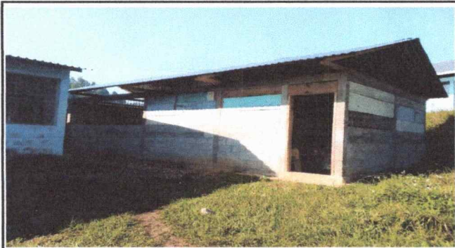
FOTO 1: SUMINISTROS Y SUSTITUCION DE CUBIERTA DE LAMINAS
