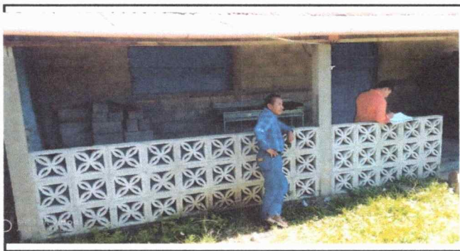
FOTO 5: SUMINISTRO Y SUSTITUCION DE SOLERA CELOCILLA DE BARANDA.
