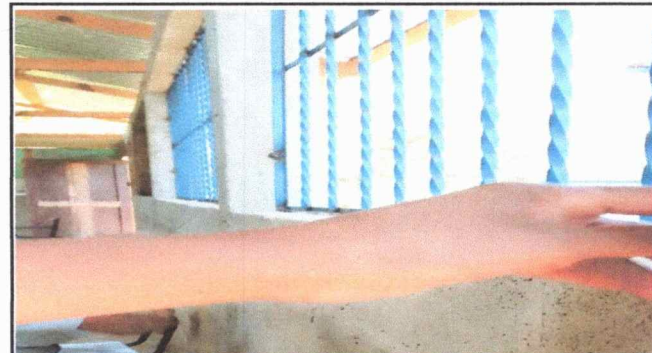
FOTO 4: SUMINISTROS Y SUSTITUCION DE VENTANAS
